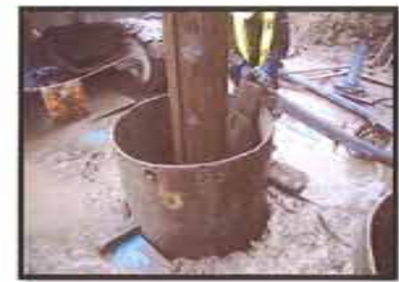
【一次スライム処理】 掘削した穴が崩れないように、 安定液を注入します。
