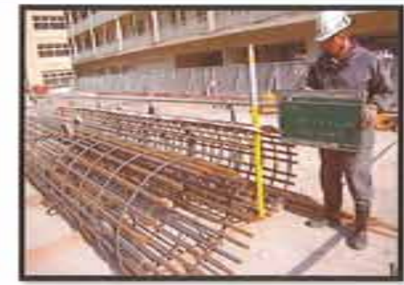
【鉄筋組立】 長いので分割して組立ます。 吊込み時につなぎます。
