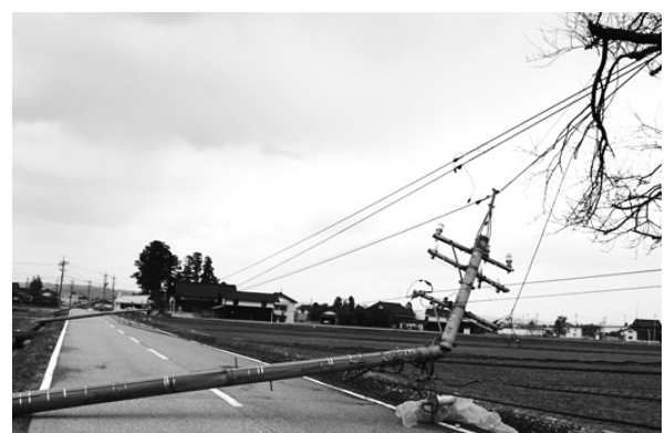
図4 コンクリートの電柱が7本なぎ倒された
