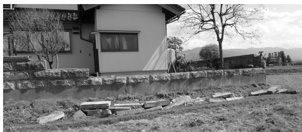
図5 家の石垣が吹き倒され、崩れた
