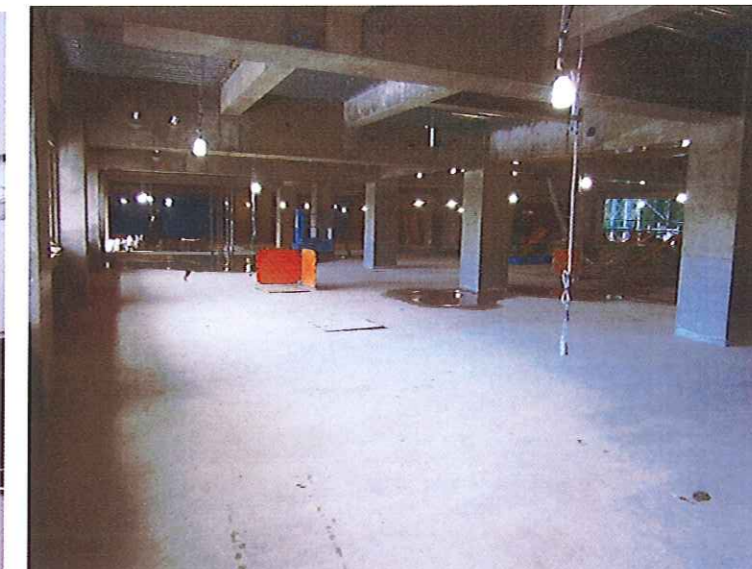
1階型枠撤出完了
