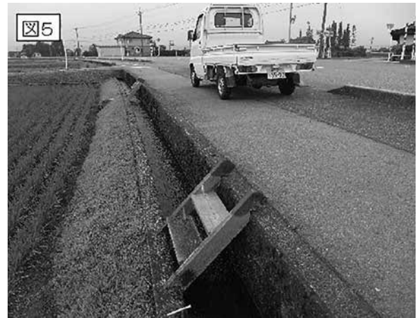
同じ落差の用水: 左には橋が架かり、右には橋が架かっていない。農地の区画整理時に「必要な箇所を調べる」との設計基準が必
