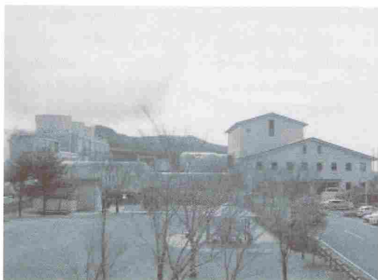
写真3 阿蘇くじゅう国立公園八丁原地熱発電所（九州電力：日本最大110,000kW）
